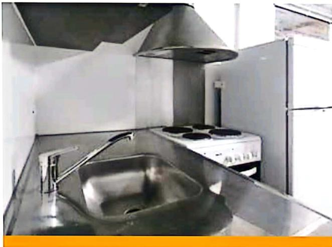
correderas telescópicas con cierre suave, y las manijas son de aluminio anodizado. La mesada es de acero inoxidable con grifería marca FV, acompañada con un revestimiento de pared sobre mesada de PRFV para una mejor limpieza y protección. Sobre la cocina eléctrica de 4 hornallas y debajo de la campana extractora de acero inoxidable, el revestimiento es también de acero inoxidable. Se incluye mesa en melamina de 36mm de espesor con estructura metálica.
